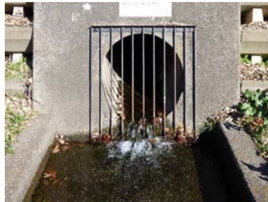
④野水橋・榛澤橋間左岸
