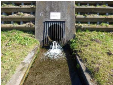
③水車小屋向い(飛橋上流左岸)
