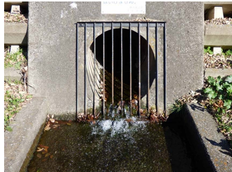
④野水橋・榛澤橋間左岸
