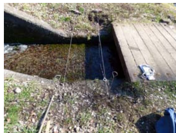
②湧水広場(くぬぎ橋下流左岸)
