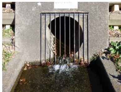
④野水橋・榛澤橋間左岸
